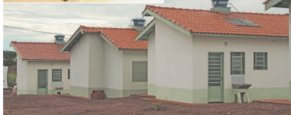
No telhado, o coletor absorve o calor e aquece a água que é armazenada no reservatório
