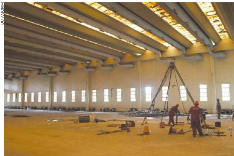
Investimento inicial no prédio que vai abrigar o Núcleo Central do Parque Tecnológico: 15,7 milhões
