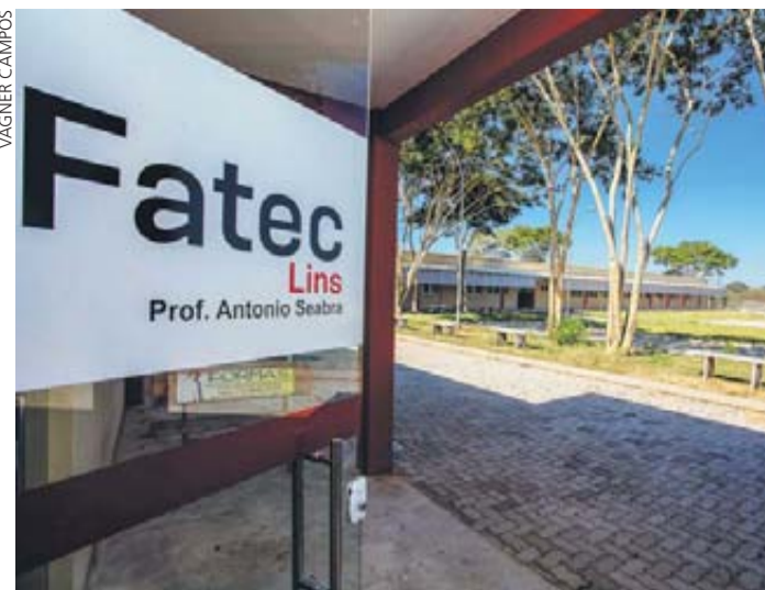
Prédio novo (Lins): 6 salas de aula, 3 administrativas e 4 sanitários
