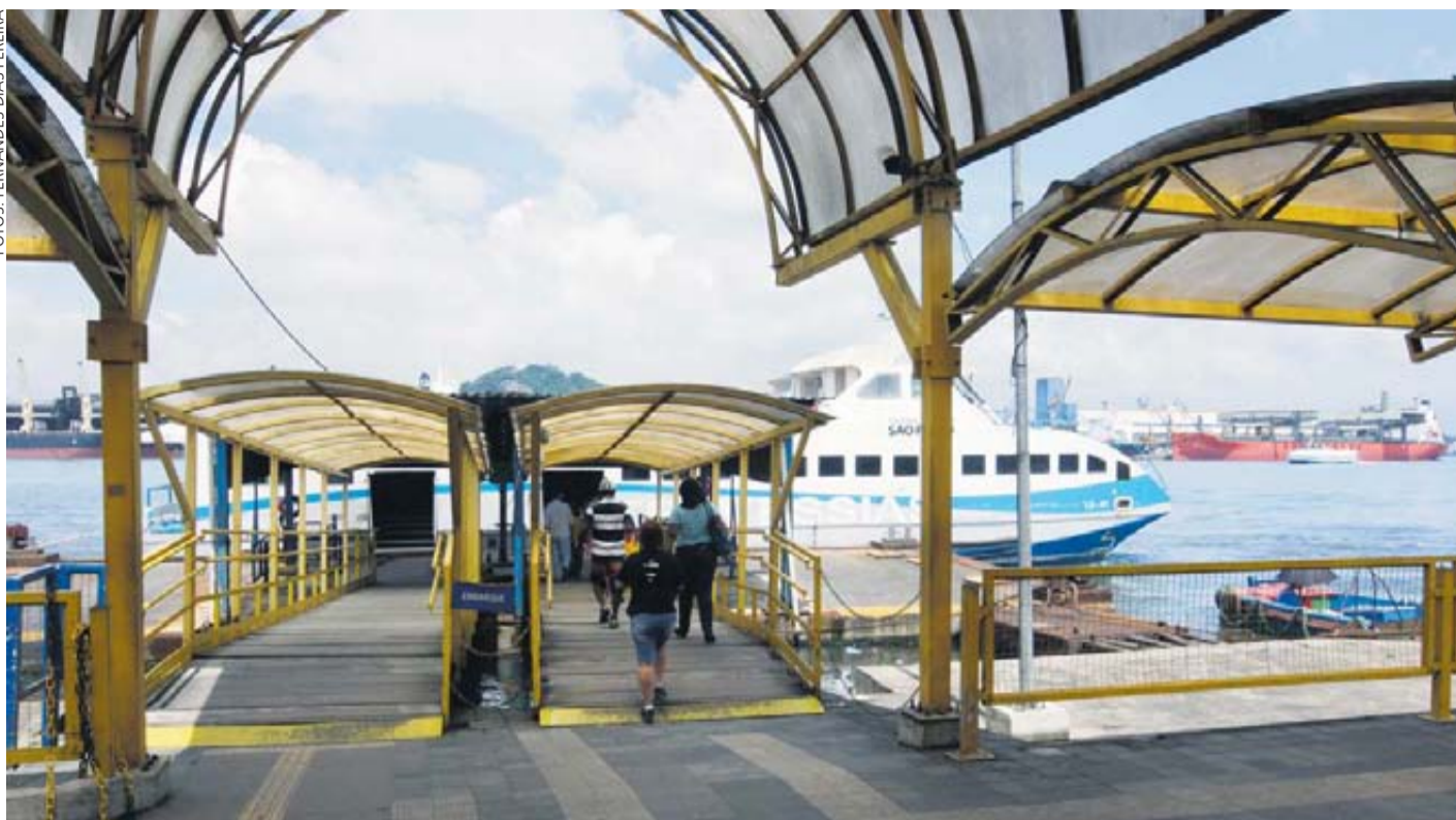
Instalada no atracadouro das balsas que fazem a travessia Santos-Guarujá, biblioteca reúne acervo variado
