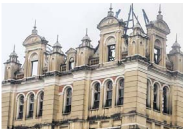
Obras vão abranger, além do Museu, a Estação da Luz
