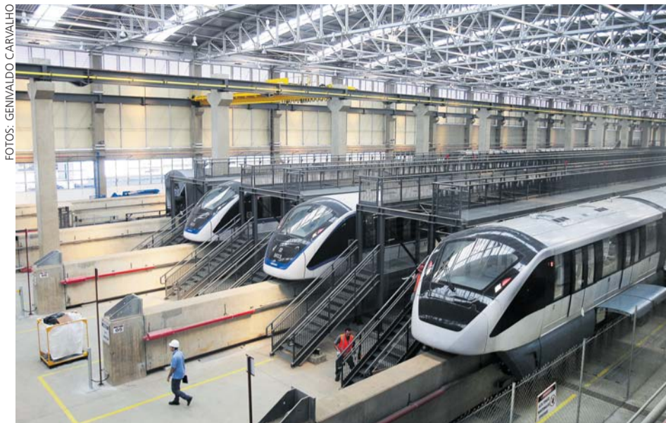
Pátio Oratório – Local destinado à manutenção preventiva e corretiva das composições
