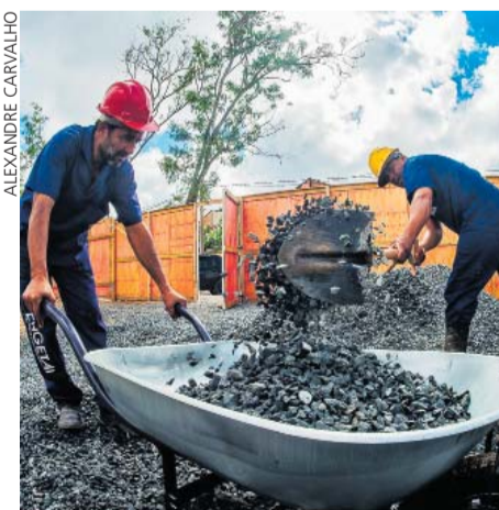
Obras vão fortalecer a rede do Estado
